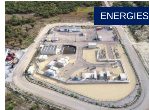
JUPITER 1000 : démonstrateur industriel de production de e-méthane dans le Sud de la France
